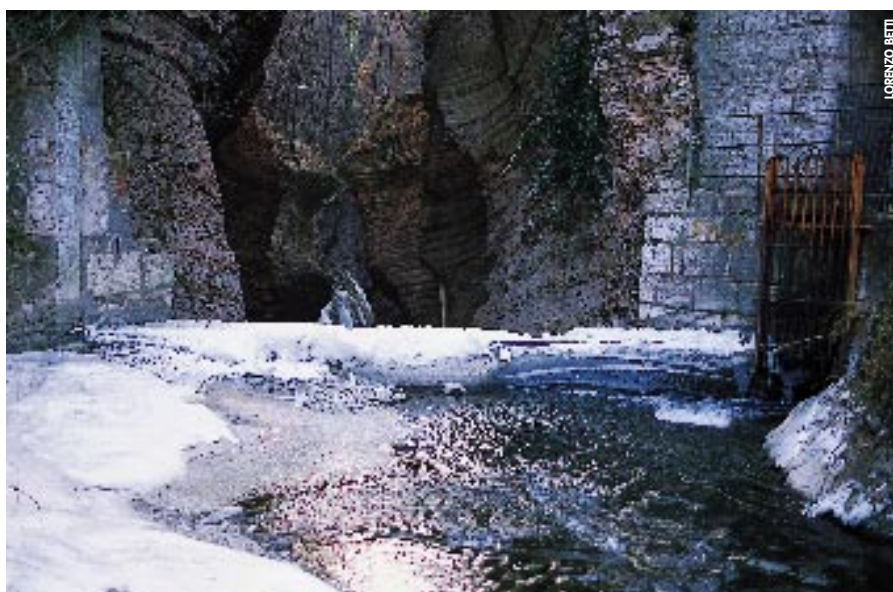
La presa "totale" di una vecchia "centralina" idroelettrica sul Torrente Fersina, a Ponte Alto: oggi non c'è nessun obbligo di rilascio.
