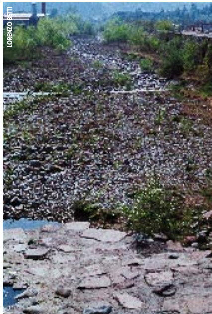
Uno dei casi più eclatanti: il Fersina a Pergine, prosciugato da prelievi idroelettrici e irrigui.
