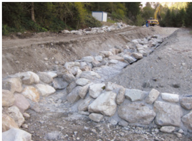
Nelle due immagini in alto e nella pagina precedente, uno dei passaggi per pesci realizzati nel 2007 sul medio corso del Vanoi. Al centro e in basso, i lavori in corso per l'esecuzione dei nuovi alvei per aggirare le grandi briglie di Canal S. Bovo.
