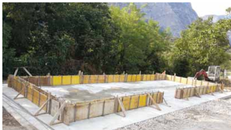
Inizio dei lavori per la costruzione dell’incubatoio
